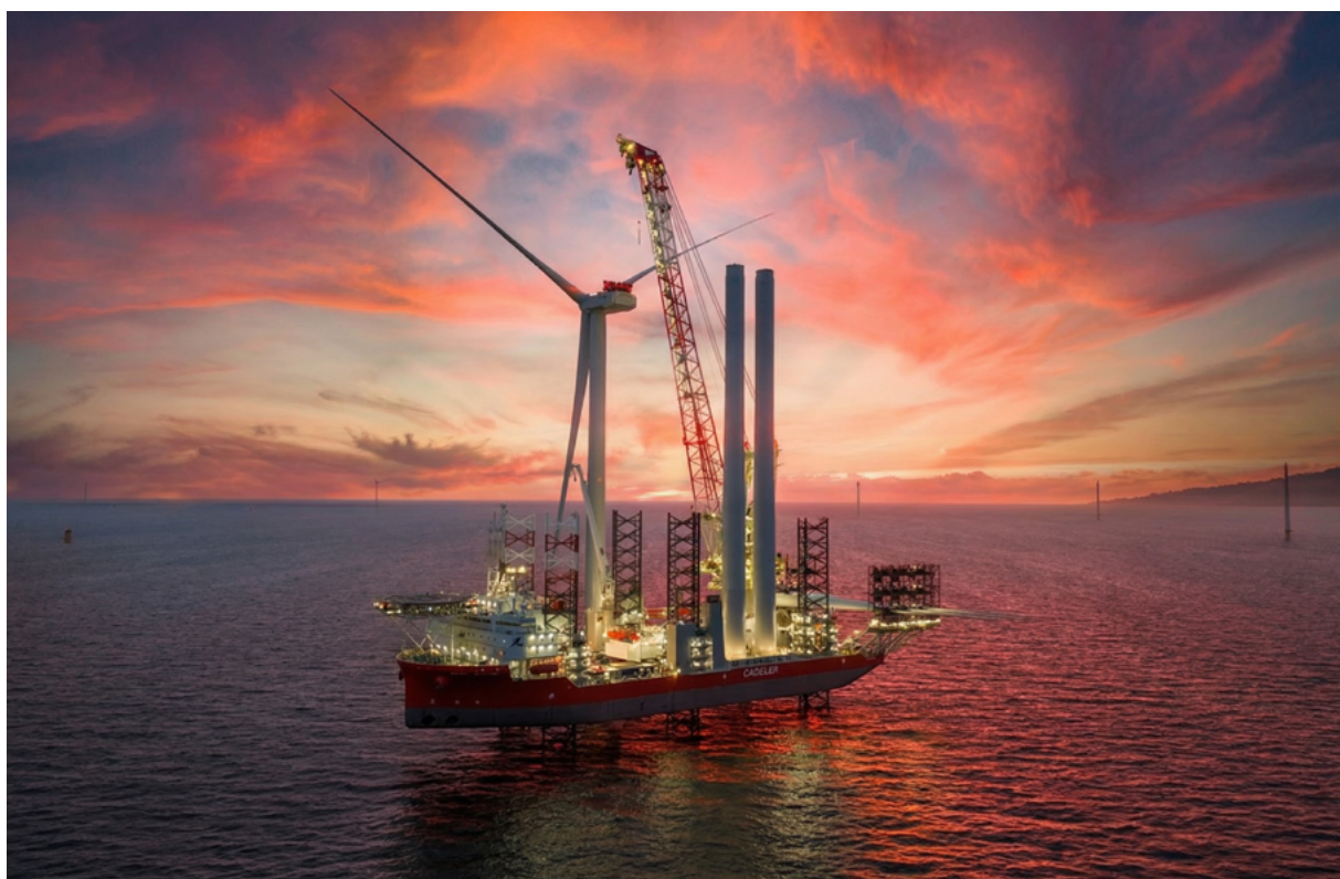
Fot. 4 Instalacja pierwszej turbiny na morskiej farmie wiatrowej Baltic Power z gondolą ze Szczecina
